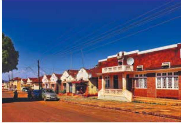
Typische Straßenfront im Norden von Jinja mit kolonialen Fassaden
